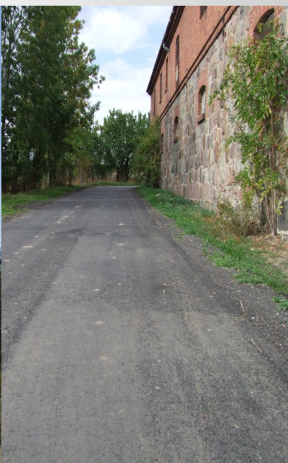
Wyremontowany odcinek drogi w Dochowej.
